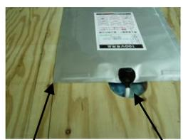
基準線に合わせてます 電源線を床下へ落とし、接続部を掘りこみにしっかりと入れます
